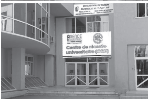
Iași. Corpul de clădiri ale Facultății de Bioingineerie Medicală și Facultății de Medicină Dentară, inaugurat în 2003. În același spațiu funcționează, din 2014, și Centrul de Reușită Universitară (Centre de Réussite Universitaire – CRU) înființat cu sprijinul Agenției Universitaire a Francofoniei (Agence Universitaire de la Francophonie – AUF) – Biroul pentru Europa Centrală și de Est.
